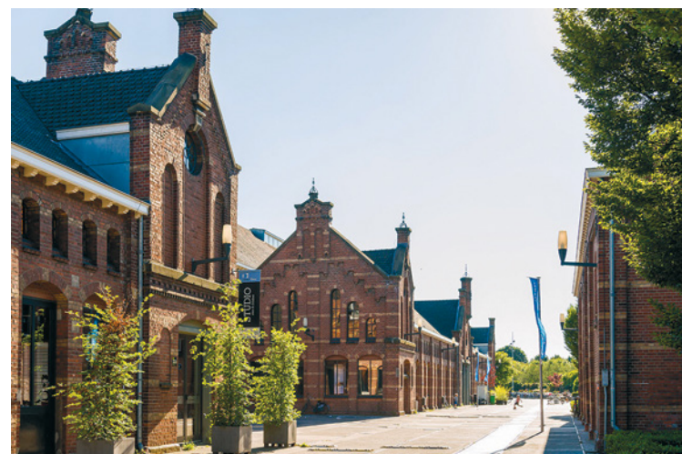
Центральный корпус парка
