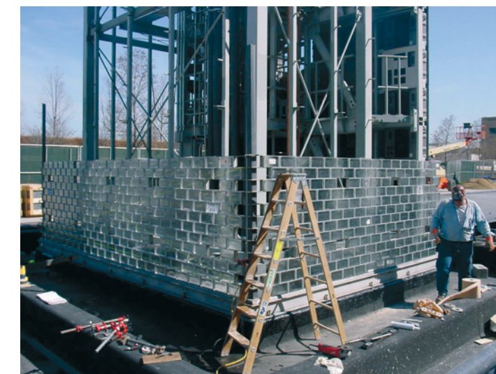
Фонтан Крауна высотой 15 метров облицован стеклянной плиткой, что позволяет проецировать медиаизображение
