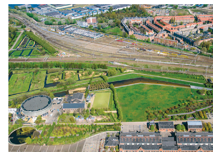
Вид на парк и его северо-западную часть, которая может быть реконструирована в дальнейшем
