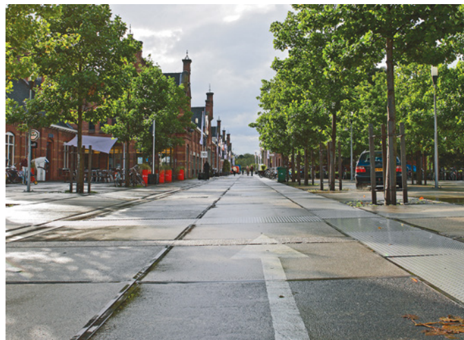
Пешеходная дорожка в направлении от центрального входа
