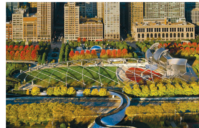
Большая лужайка у павильона Притцкера перекрыта системой стальных опор, на которые крепится акустическое и другое техническое оборудование
